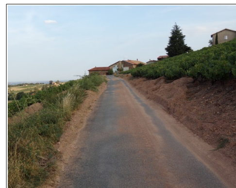
Illustration 124: chemin de la ferme des Ribérolles (versant d'Espagne) exposées aux ruissellements et à l'ensablement.
