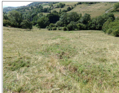
Illustration 21: zone d'instabilité par fluage au lieu-dit Le Venet.
