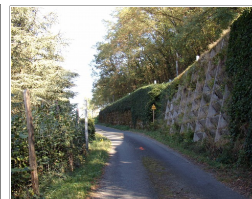
Illustration 142: ouvrage de soutènement de la RD 35 à l'ouest du village.
