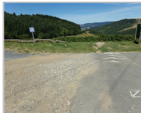
Illustration 96: axe de ruissellement provenant du chemin de la colline de Bois Boulon et se dirigeant vers la combe du village.
