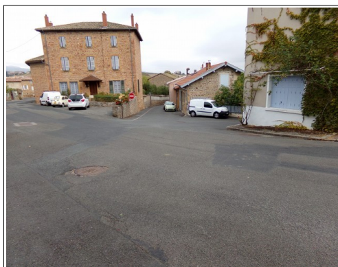
Illustration 135: exemple de rue du village pouvant être empruntée par des écoulements (carrefour rue du 8 mai 1945 - Grande rue).
