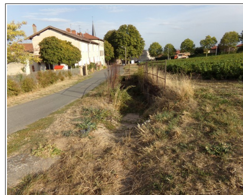
Illustration 109: vue d'un des axes hydrauliques débouchant dans le village avec présence d'un petit bassin d'orage / décantation.
