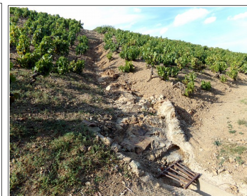
Illustration 122: aménagement hydraulique sommaire dans le vignoble du versant d'Espagne pour contrôler les ruissellements.
