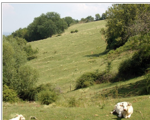
Illustration 166: glissement de terrain de la combe de Chez le Bois, on notera les ondulations caractéristiques du terrain.
