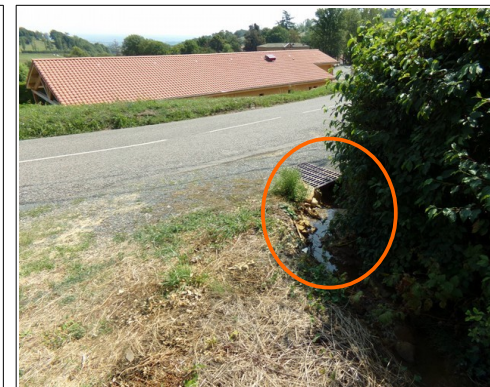
Illustration 161: débouché d'un fossé (axe hydraulique drainant le secteur de Chez le Bois) au droit du lotissement du Vivier (partie récente du village). On notera son étroitesse.
