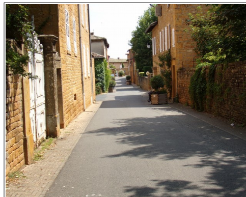
Illustration 160: RD 19 et point bas dans le village, par lesquelles peuvent se diffuser des ruissellements.
