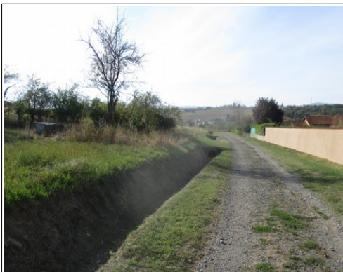
Illustration 64: Fossé le long du chemin des vignes
