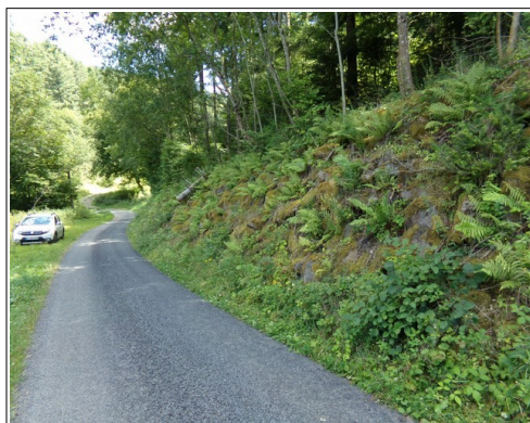
Illustration 101: enrochement du talus amont du chemin communal des Aigais près du lieu-dit Vers le Bois.
