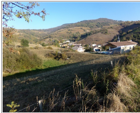
Illustration 87: bassin d'orage aménagé dans le quartier Le Pinay / Le Moulin en rive droite du Nizerand.
