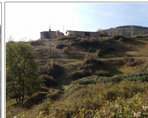
Illustration 90: signes de fluage en rive droite du Nizerand, au droit du château de Cerfavre. Les déformations de terrain sont accentuées par des terrassements réalisés.
