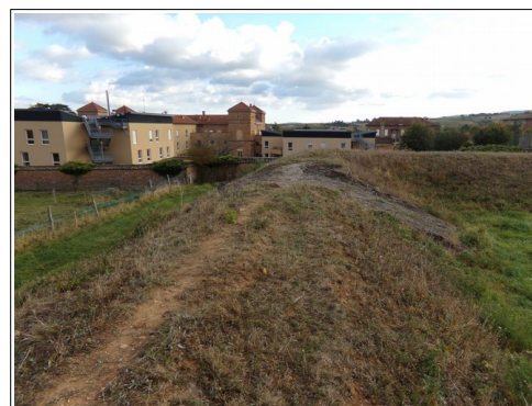
Illustration 10: bassin d'orage à l'amont de la maison de retraite.
