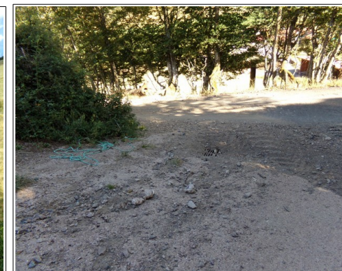
Illustration 97: ruissellements en tête de bassin versant de la combe du Creux.
