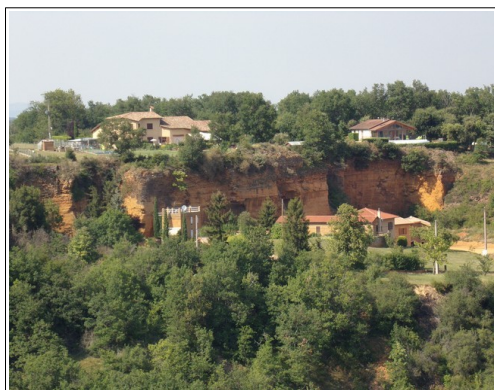
Illustration 170: carrière des Placettes et habitations construites dans son emprise.
