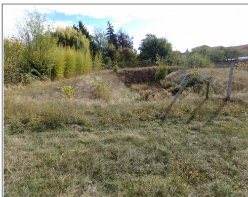
Illustration 47: bassin d'orage aménagé à l'amont immédiat du village.
