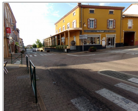
Illustration 111: les écoulements de la place de l'Eglise peuvent ensuite se poursuivre sur la RD43 et se diffuser à l'aval.
