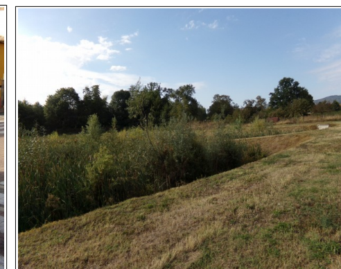
Illustration 112: bassin de rétention au pied du village (secteur des Grandes Bruyères).
