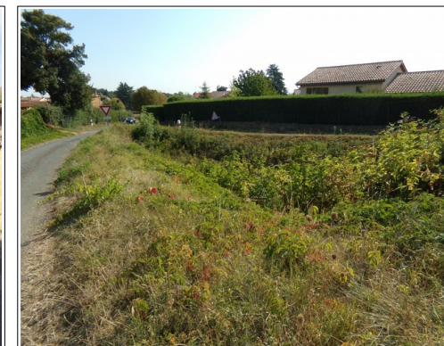
Illustration 49: petit bassin d'orage aménagé en bordure de la RD84E à l'amont du village.
