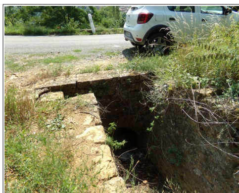
Illustration 163: franchissement de la RD19 par la combe de Remont à l'amont du lotissement du Vivier.
